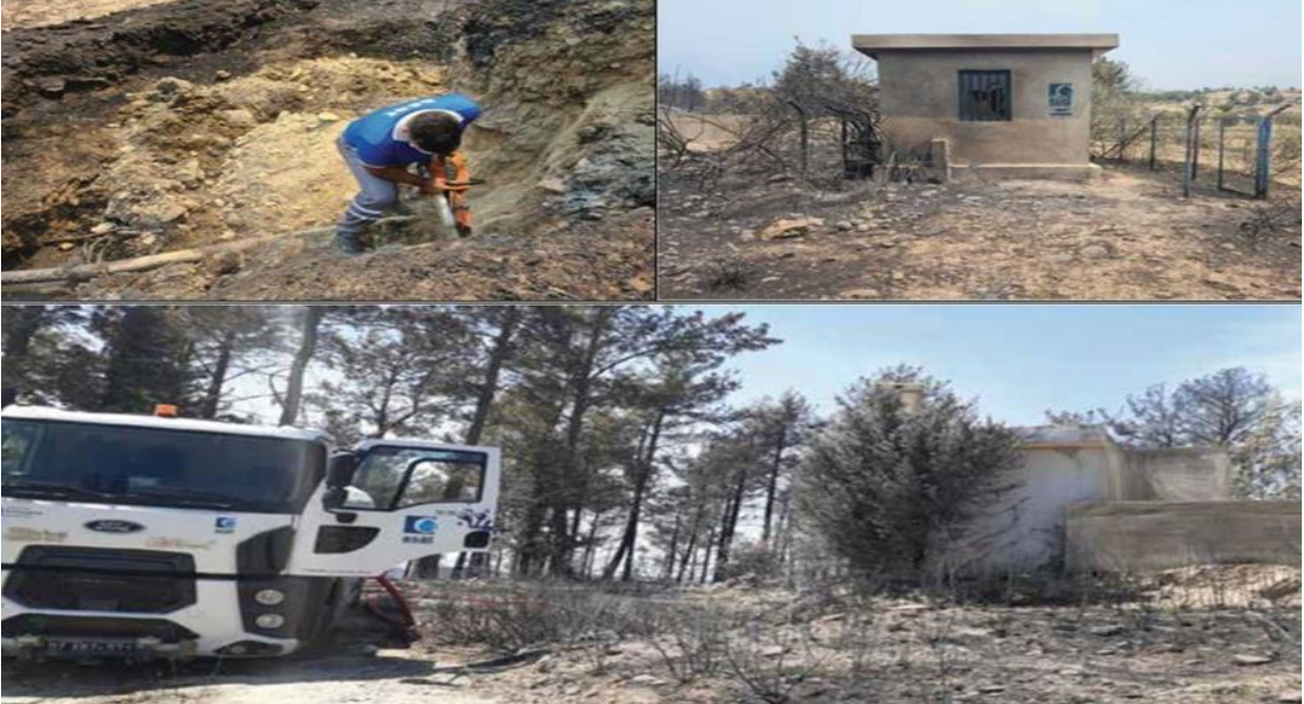
Şekil 2: Yangın Afeti Sonrası Etkilenen Altyapı Durumu (İçme Suyu Hatları, Depo ve Terfi İstasyonları Görselleri)
